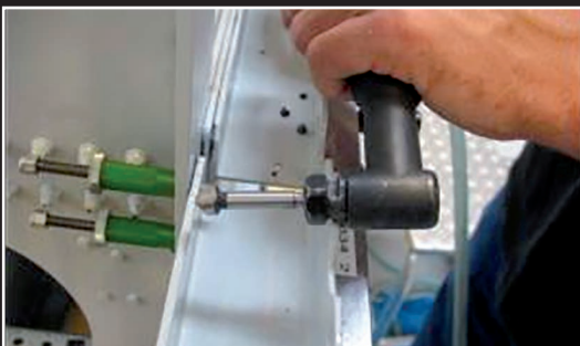
Schlechter Zugang mit ungenauer Bearbeitung / Severely limited Accessibility, Questionable quality of work / Mauvais accès avec traitement inexacte / Acceso malo con gestión impreciso
